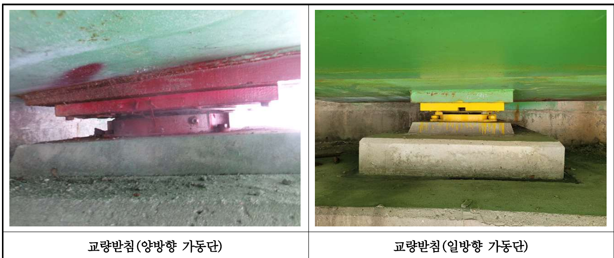
【사진 1.3.13】 교량받침 전경
