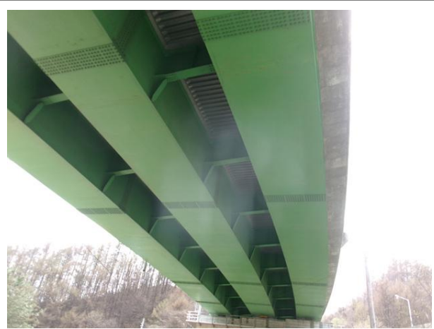
바닥판 하면 및 거더 전경
