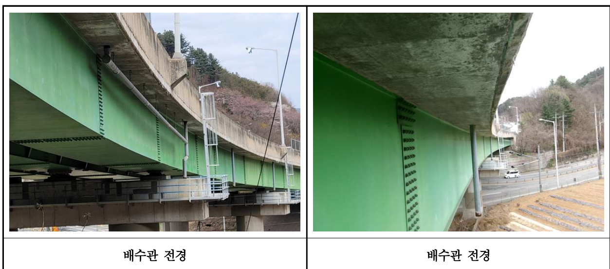
【사진 1.3.19】 배수시설 전경
