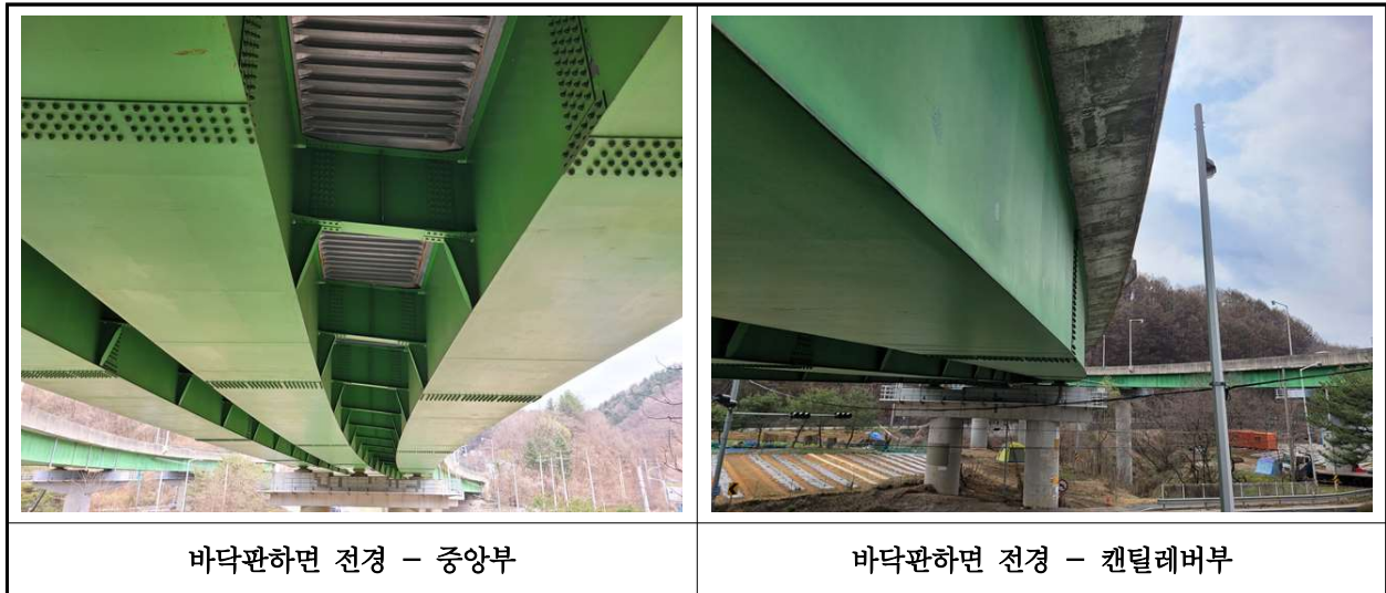
【사진 1.3.2】 바닥판하면 전경
