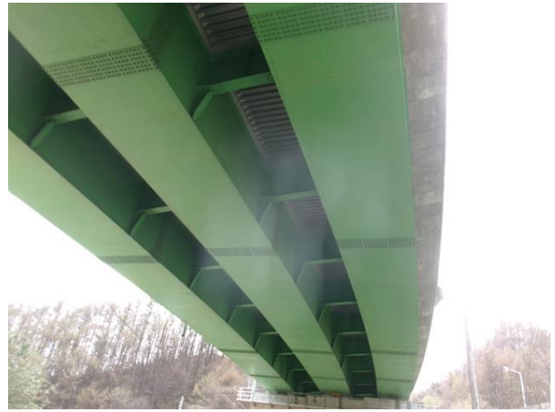
바닥판 하면 및 거더 전경
