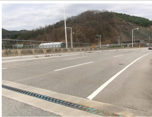
교량 상부 전경
