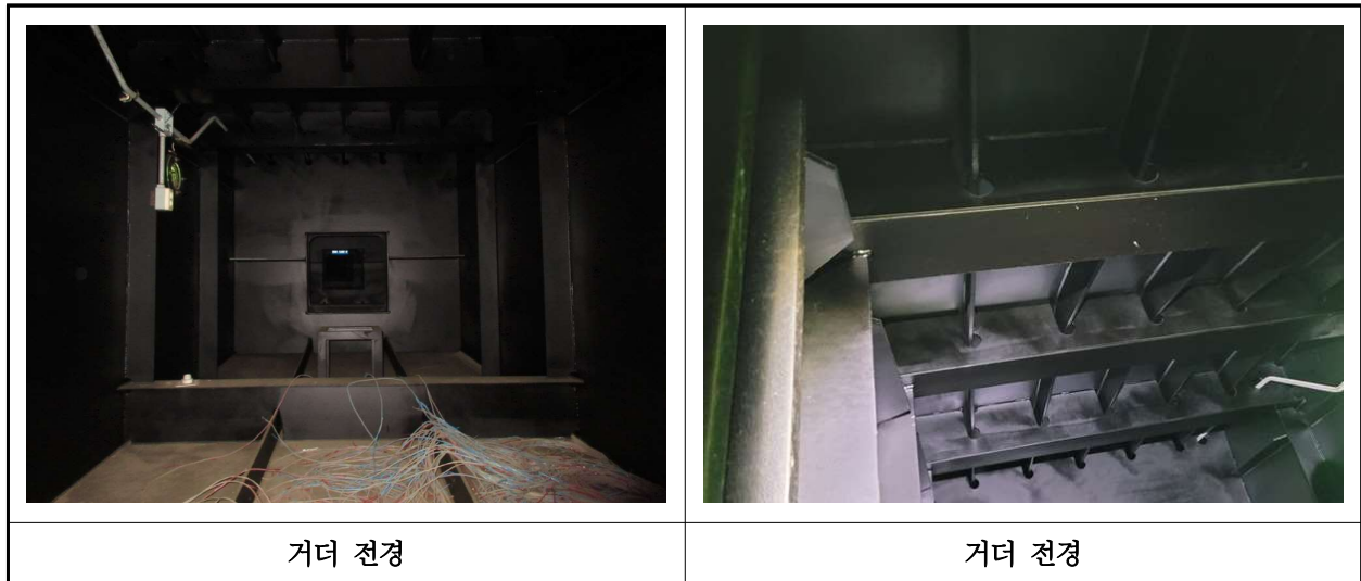
【사진 1.3.6】 거더 전경
