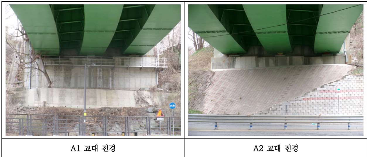
【사진 1.3.9】 교대 전경
