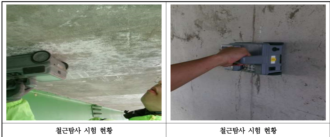
【사진 1.4.2】 철근탐사 시험
