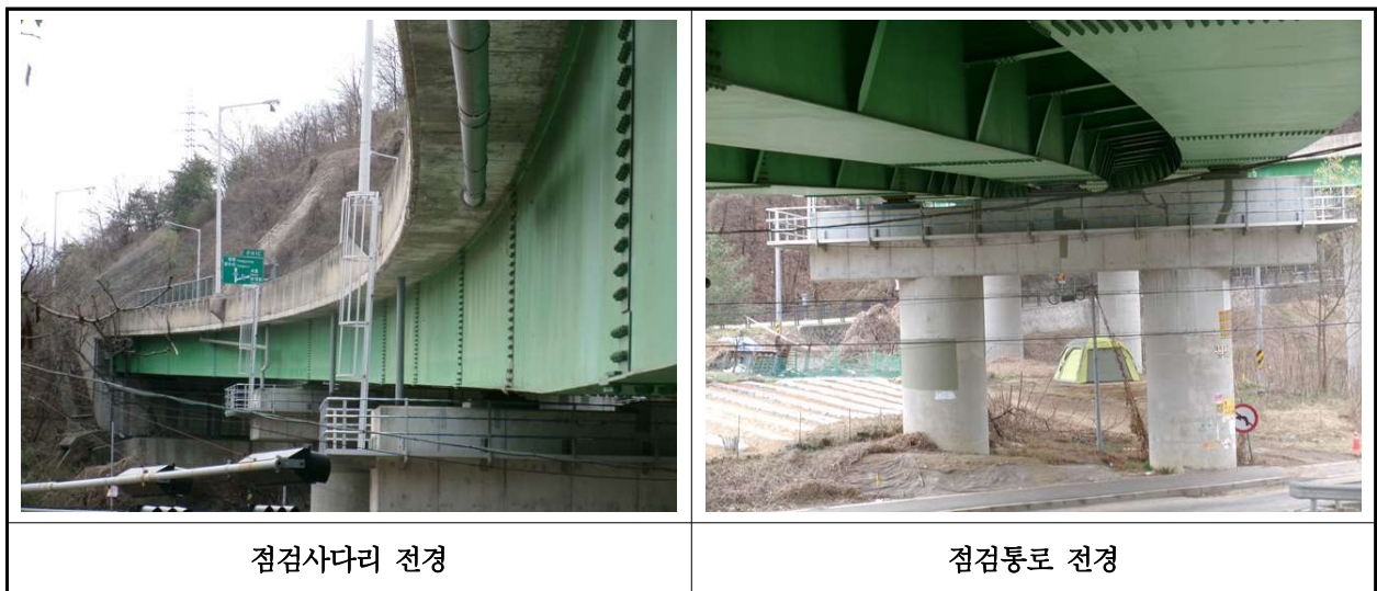
【사진 1.3.23】 교량 점검시설 전경
