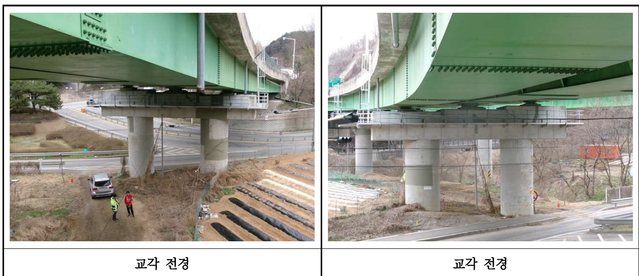
【사진 1.3.11】 교각 전경
