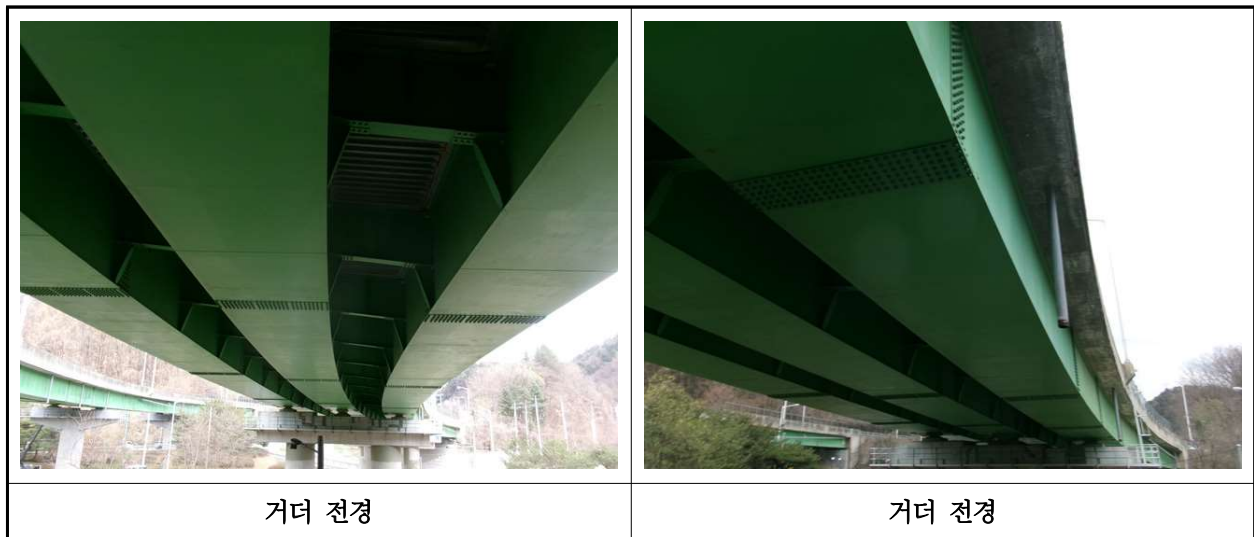
【사진 1.3.4】 거더 전경
